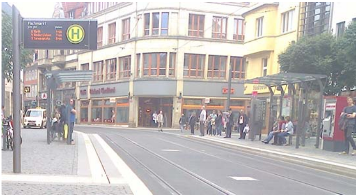
Abbildung 12: Beispiel für visuellen Kontrast zwischen Gleisbereich und Bahnsteigkante
