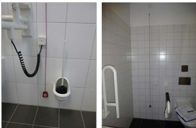
Abbildung 7 Beispiele für Anordnung des Auslösemechanismus der Notrufanlage
